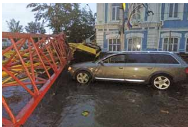
Рис. 33. Падение крана при сходе с рельсового пути из-за шквалистого порыва ветра в г. Барнауле
